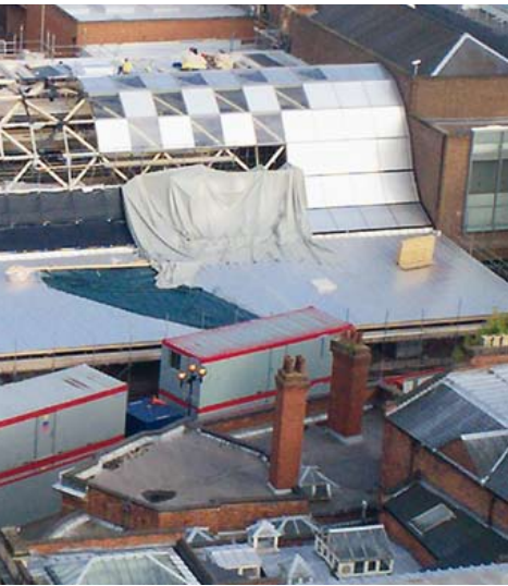
◀ Die Montage der Konstruktion erfolgte auf einem Lehrgerüst zur temporären Abstützung
