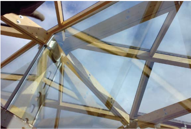
◀ Der Anschluss Fassade an Dach bestimmt die maximalen Verformungen
