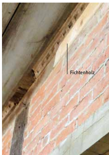
◀ Falsch: Eichenholz wurde durch Nadel-schnittholz ersetzt
