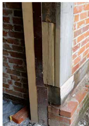
▶ Der Eckstiel ist nicht fachgerecht bearbeitet worden
