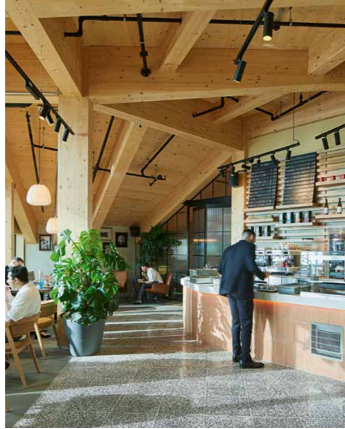
▲ Die leichte Holzkonstruktion kombiniert Brettspertholzplatten und Brettschichtholzträger
