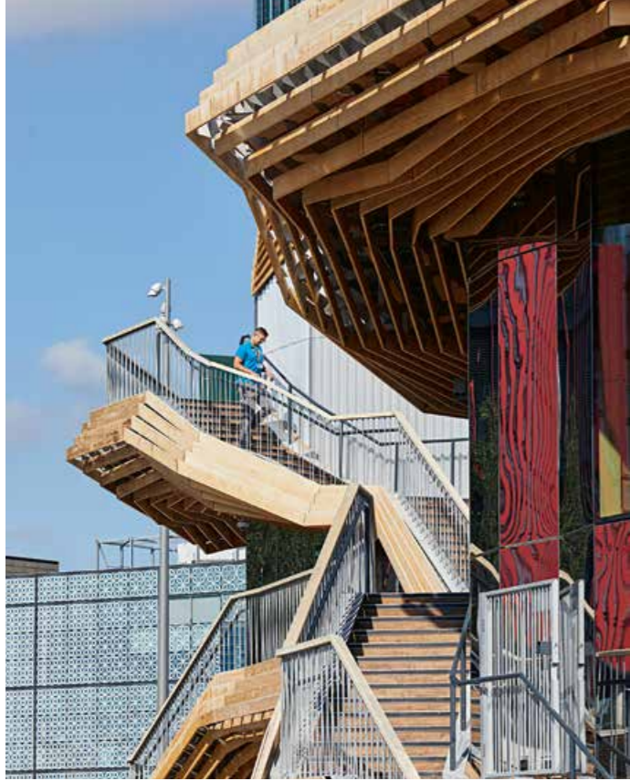
▲ Das Holz der Fassadenlamellen musste lediglich mit einer Brandschutzbeschichtung behandelt werden und ist weitgehend wartungsfrei
