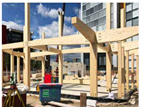
▲ Das Gerüst besteht aus Stützen und Balken mit unterschiedlichen Stärken
