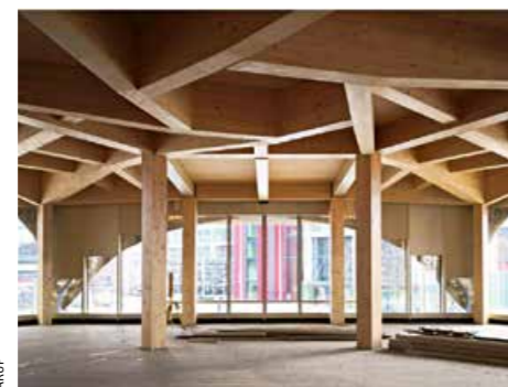
▲ Während die Geschosse außen auskragen, formen sie innen ein Sechseck
